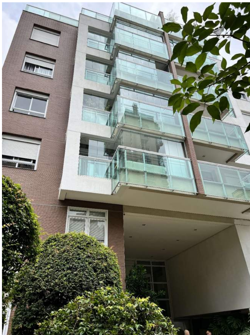
ASPECTOS GERAIS FACHADA
