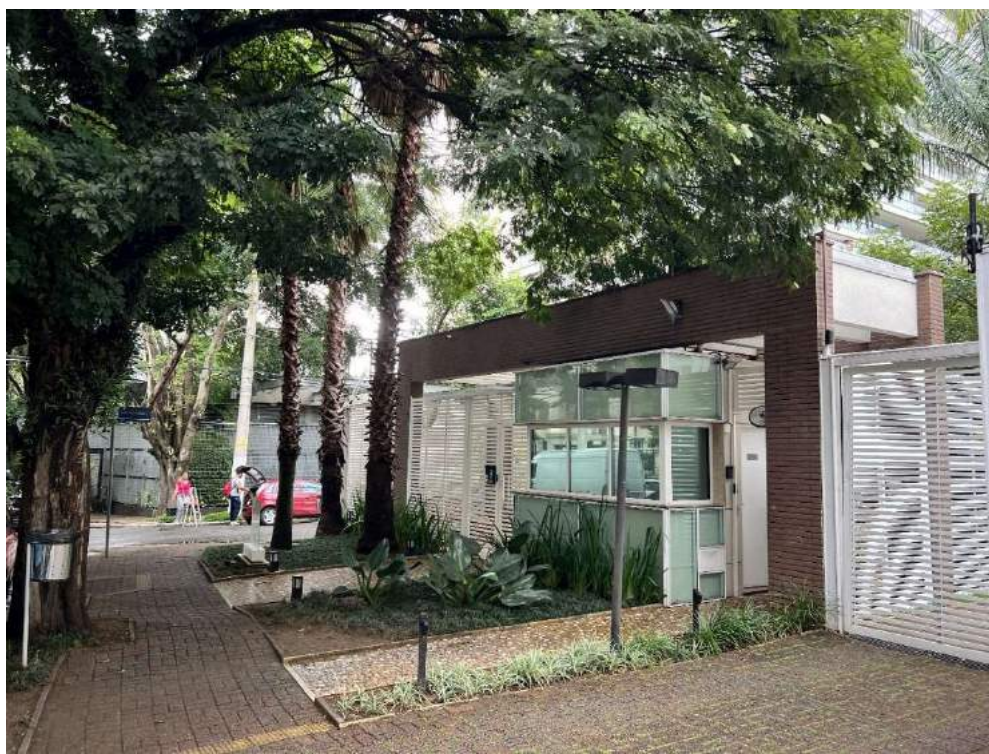
ASPECTOS GERAIS FACHADA
