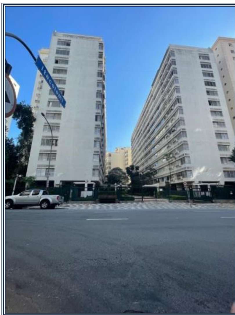
Vista do Condomínio onde se localiza o imóvel avaliando.
