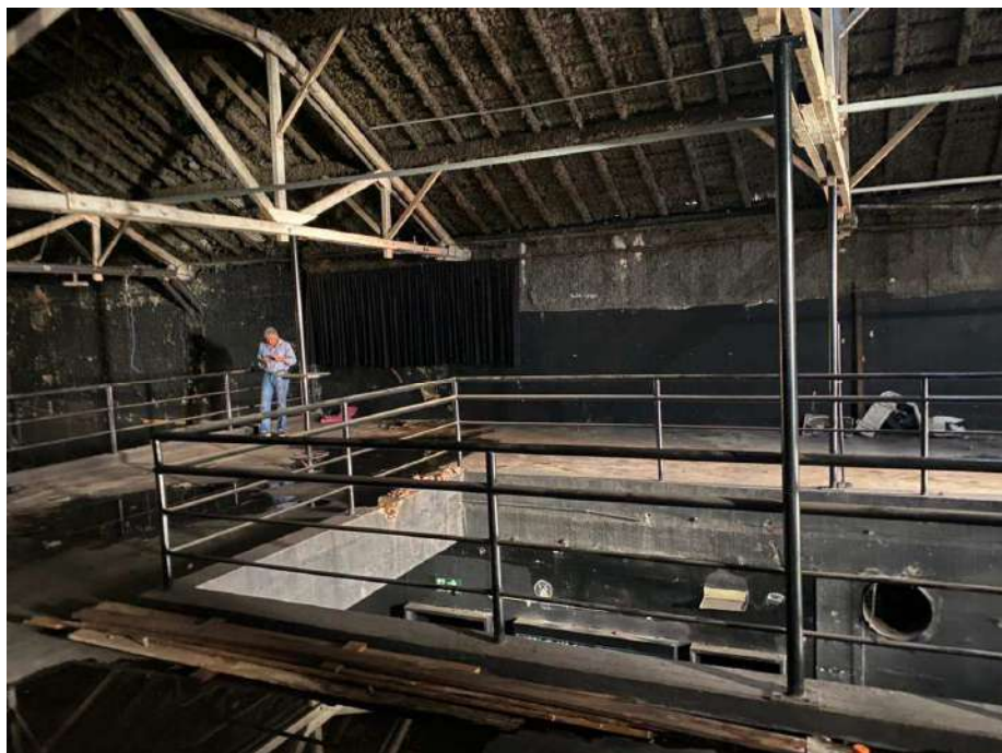
VISTA DO MEZANINO.
