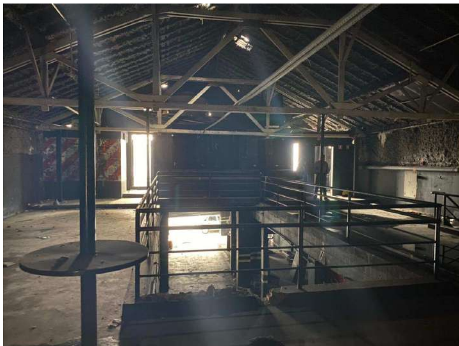
VISTA DO MEZANINO.
