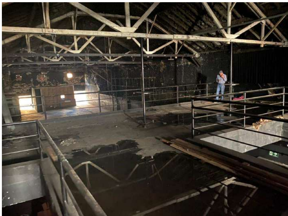
VISTA DO MEZANINO.
