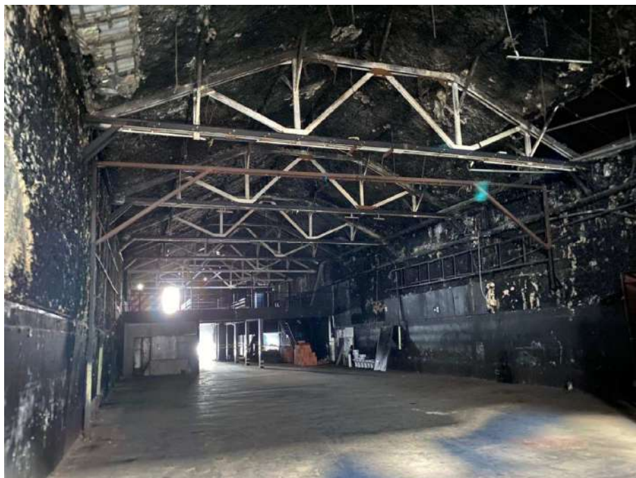
VISTA DO GALPÃO.
