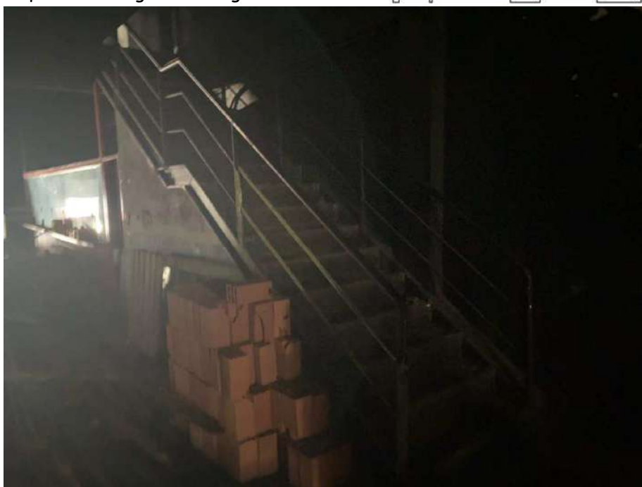
VISTA DA ESCADA DE ACESSO AO MEZANINO.
