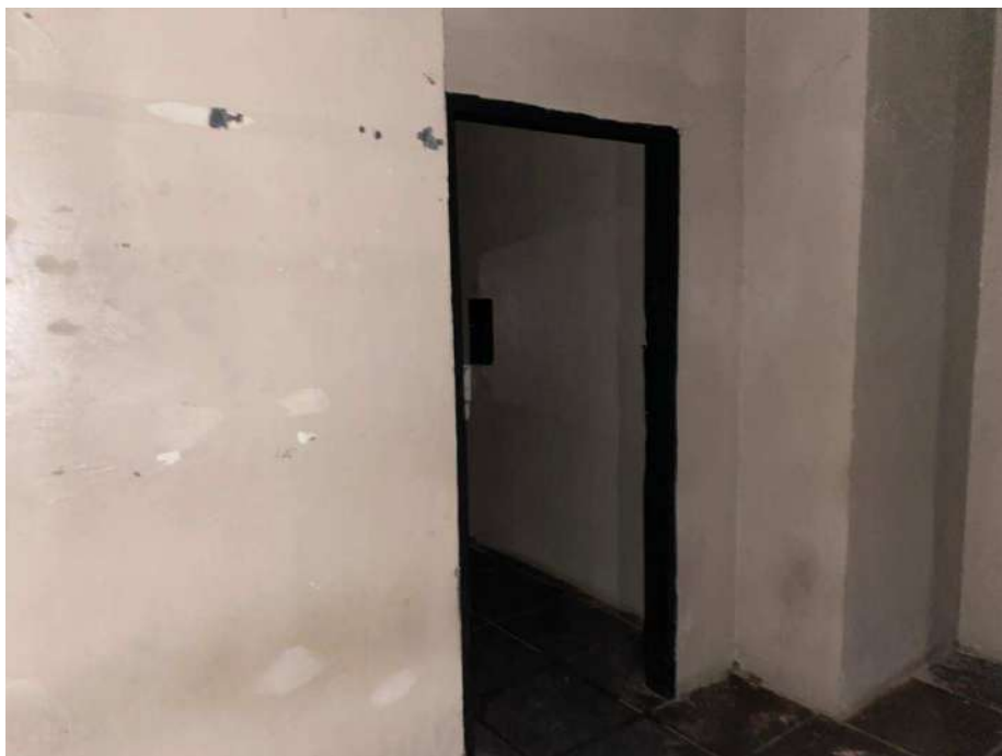
VISTA DA PORTA DE ACESSO AO BANHEIRO MASCULINO.
