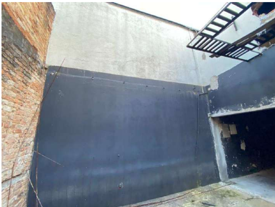
VISTA DOS FUNDOS DO IMÓVEL.
