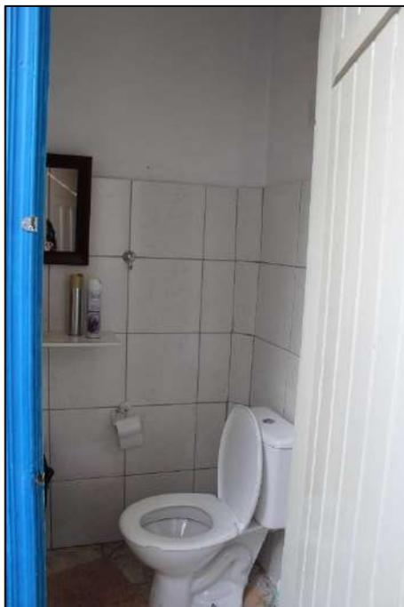
FOTO 16: Vista da laje do banheiro da área externa, observa-se trinca na laje e na parede e umidade no revestimento.
