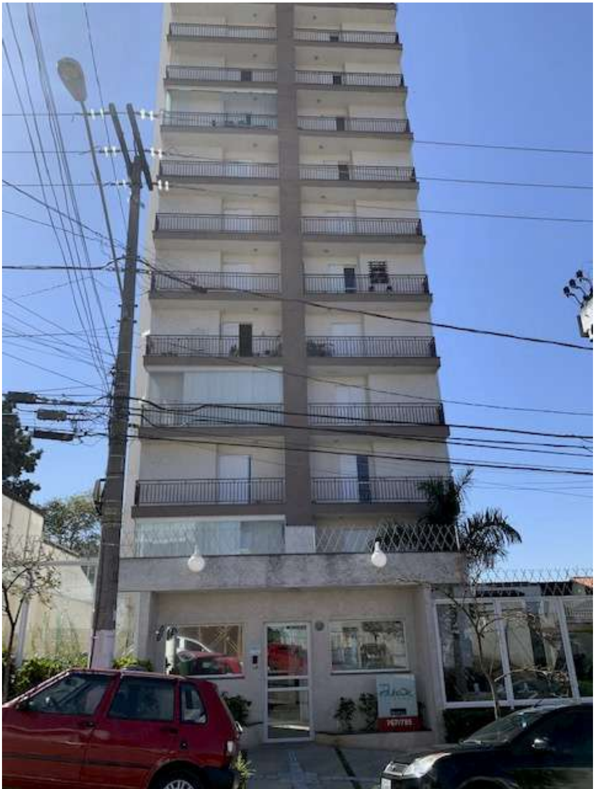
Foto 5: Vista da entrada ao Condomínio Pasi3n Ypiranga - Rua Cisplatina,767.
