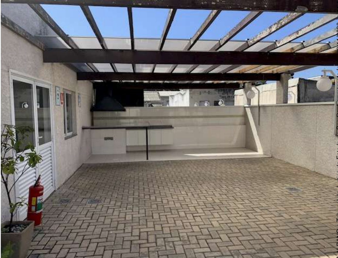
Foto 34: Vista geral da churrasqueira do Condomínio Pasion Ypiranga.
