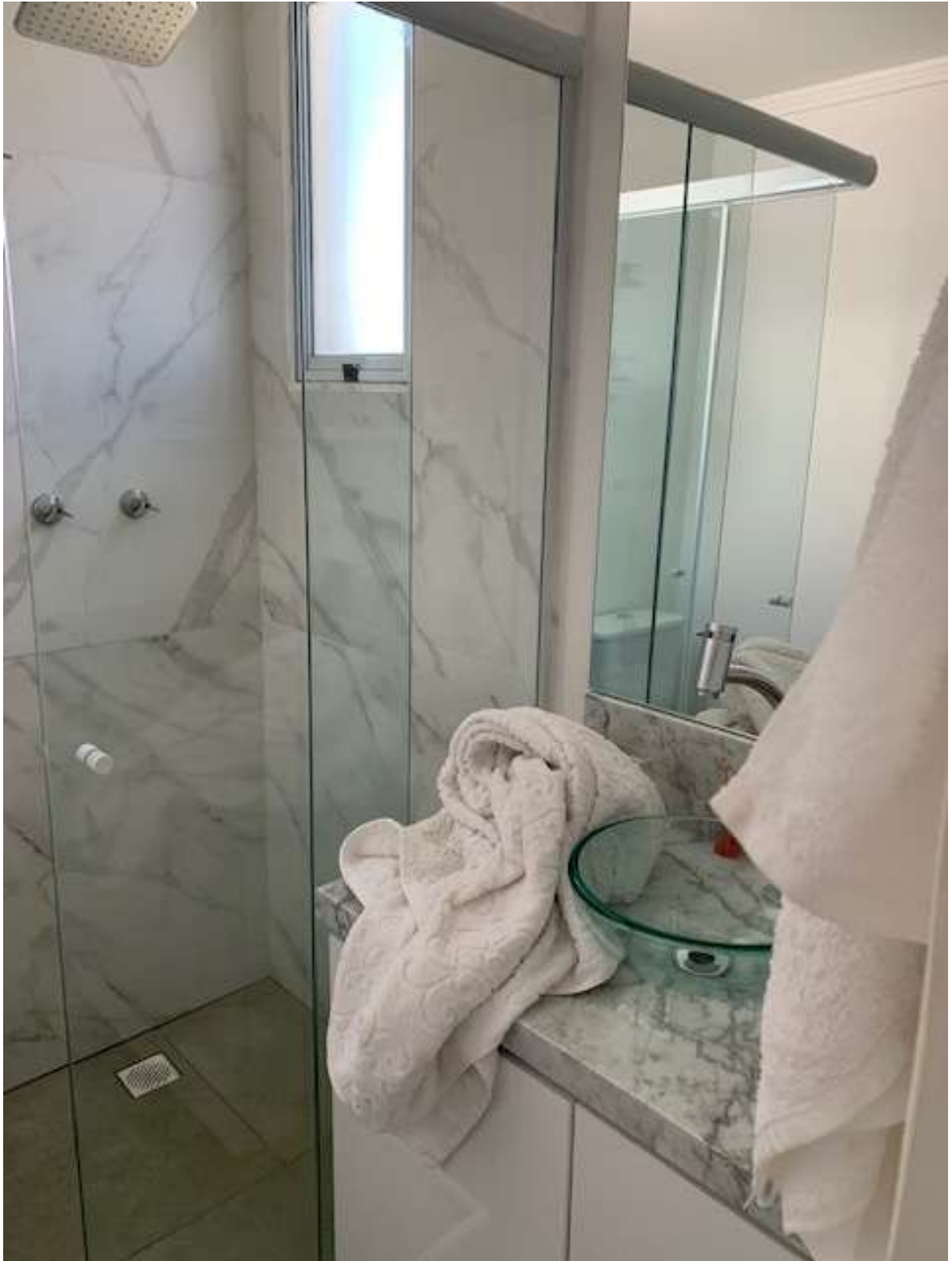
Foto 26: Vista do banheiro do apartamento 151 do Condomínio Pasion Ypiranga.
