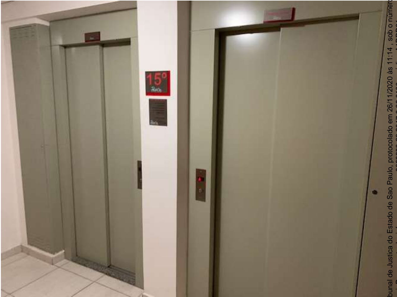
Foto 15: Vista do hall de elevadores no 15° andar do Condomínio Pasion Ypiranga.
