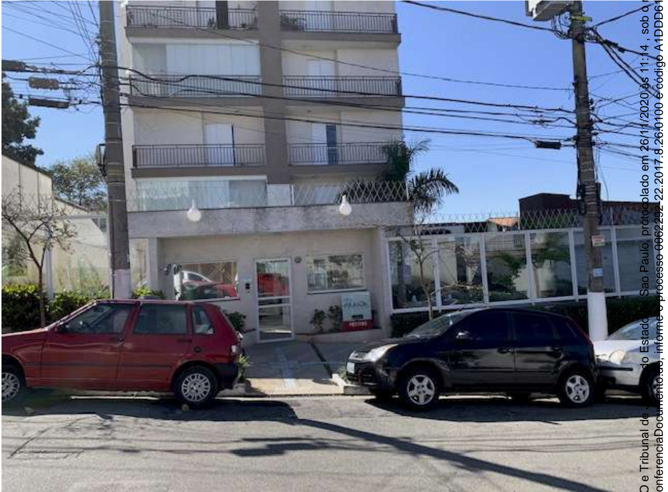
Foto 4: Vista da entrada ao Condomínio Pasi3n Ypiranga- Rua Cisplatina,767.
