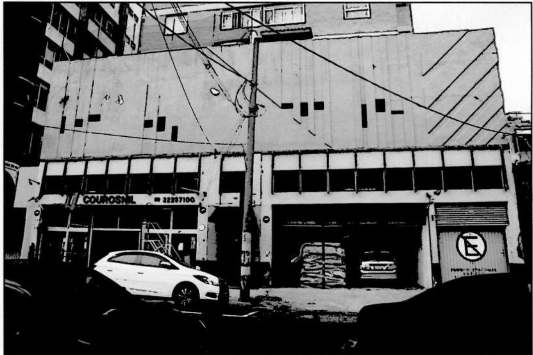
FOTOS 1/2/3 - Vista do Edifício Antonio Costa.
