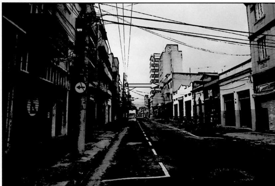
FOTOS 4/5 - Vista da Rua Carneiro Leão. A seta amarela indica o Edifício Antonio Costa.
