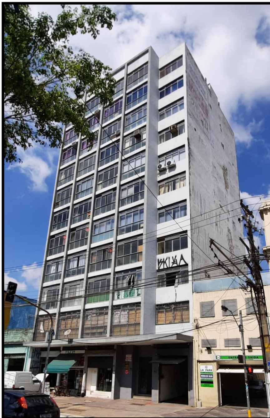
IMAGEM 1- VISTA FRONTAL DO EDIFÍCIO
