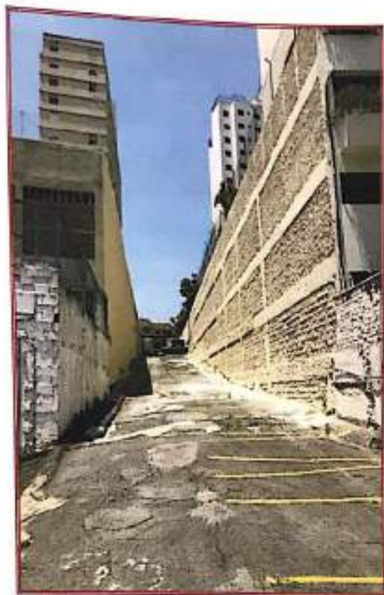
Foto nº 13: Vista geral do acesso ao imóvel com detalhe para sua topografia em declive.
