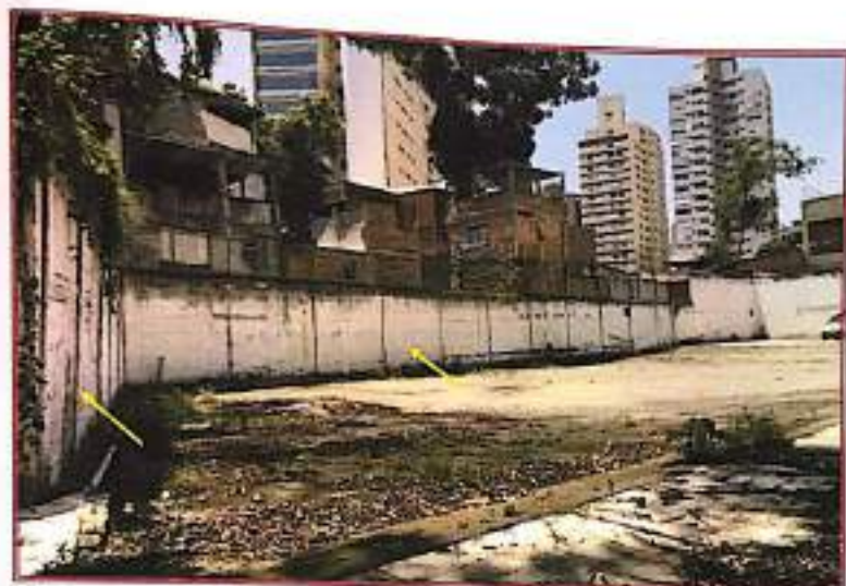
Foto nº 10: Vista do muro de divisa de fundos que confronta o córrego canalizado denominado "sapateiro" e da lateral direita.
