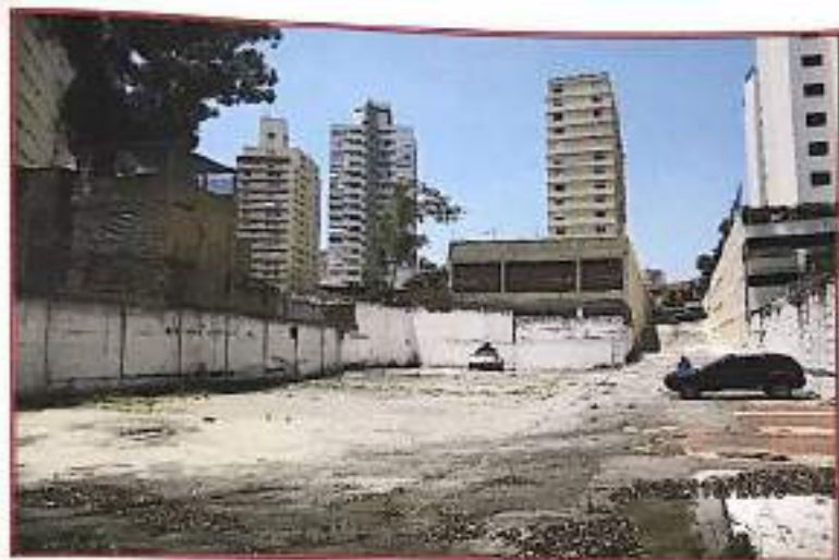
Foto nº 11: Outra vista geral da área de terreno, com detalhe para o acesso aos fundos e condomínios residenciais confrontantes.
