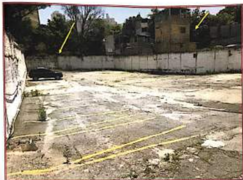
Foto nº 09: Vista geral da área de terreno, com detalhe para os muros de divisas da lateral direita, onde se observa a presença de construções populares e de fundos que confronta o córrego canalizado denominado "sapateiro".
