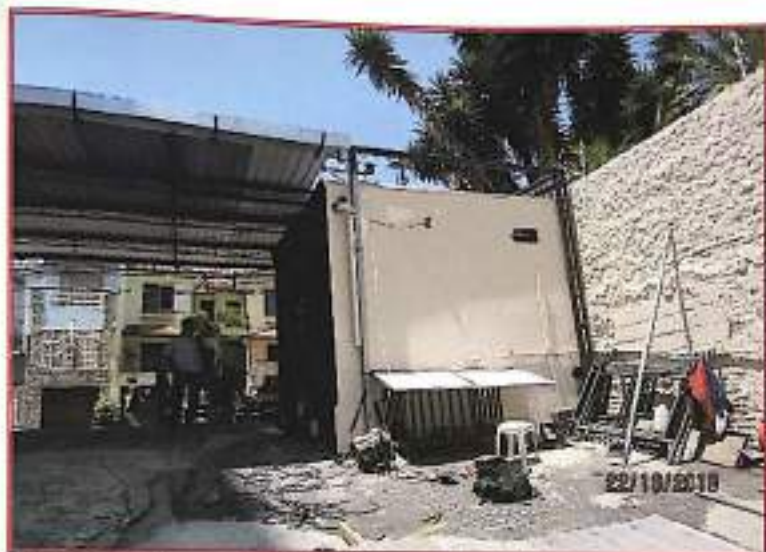
Foto nº 06: Vista parcial da área de terreno, com detalhe para o seu acesso e construções.
