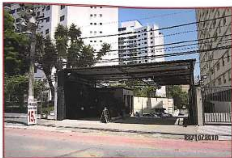
Foto nº 01: Vista geral da fachada do imóvel avaliando.
