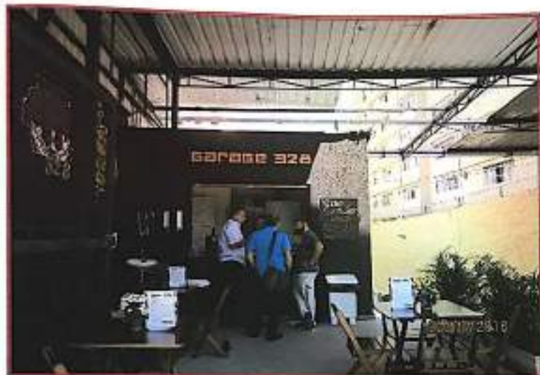
Foto nº 04: Vista parcial da área coberta frontal e guarita (adaptada para mini lanchonete) e cobertura em fase final de implantação.
