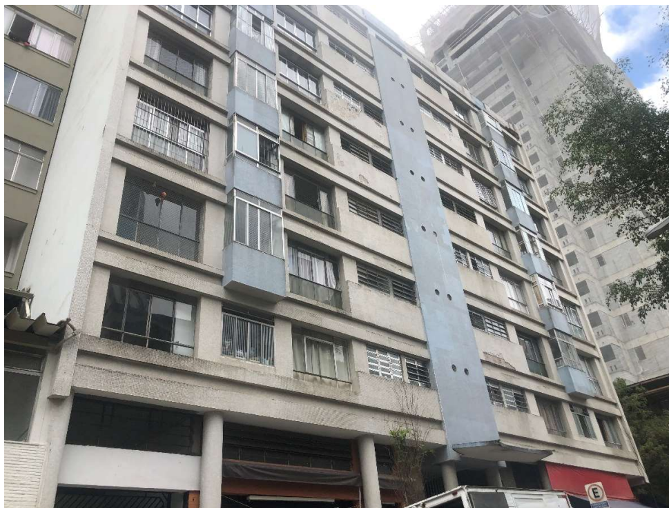
Foto 1: Fachada do Condomínio Edifício Comendador Córdia
