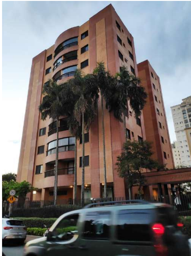
Figura 6 – Torre única do Condomínio Residencial Piemonte
