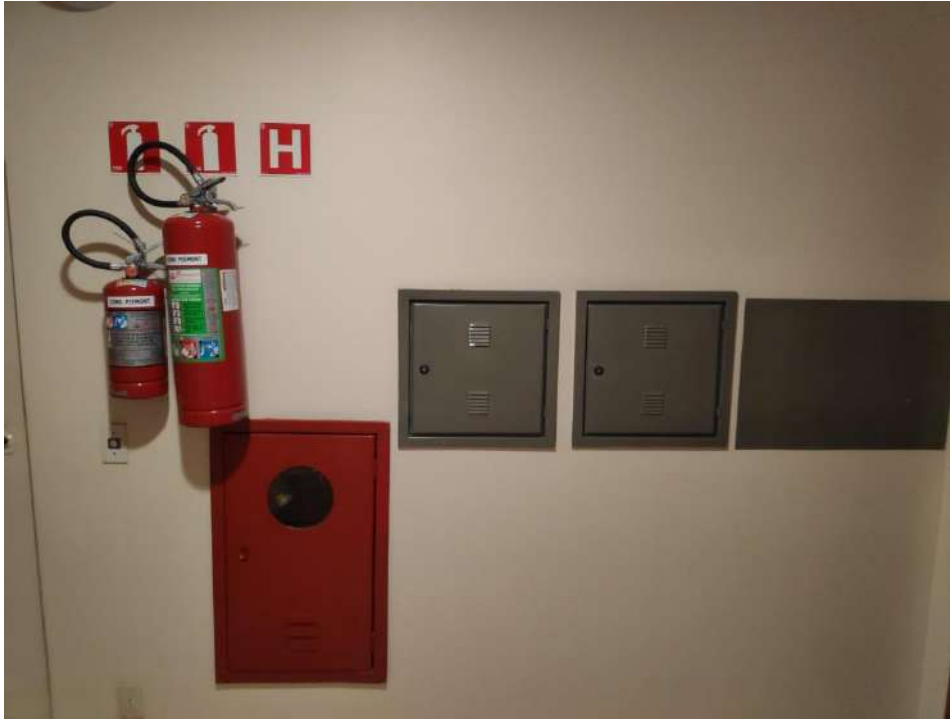
Figura 53 – Shafts, hidrante e extintor (andar objeto de exame)
