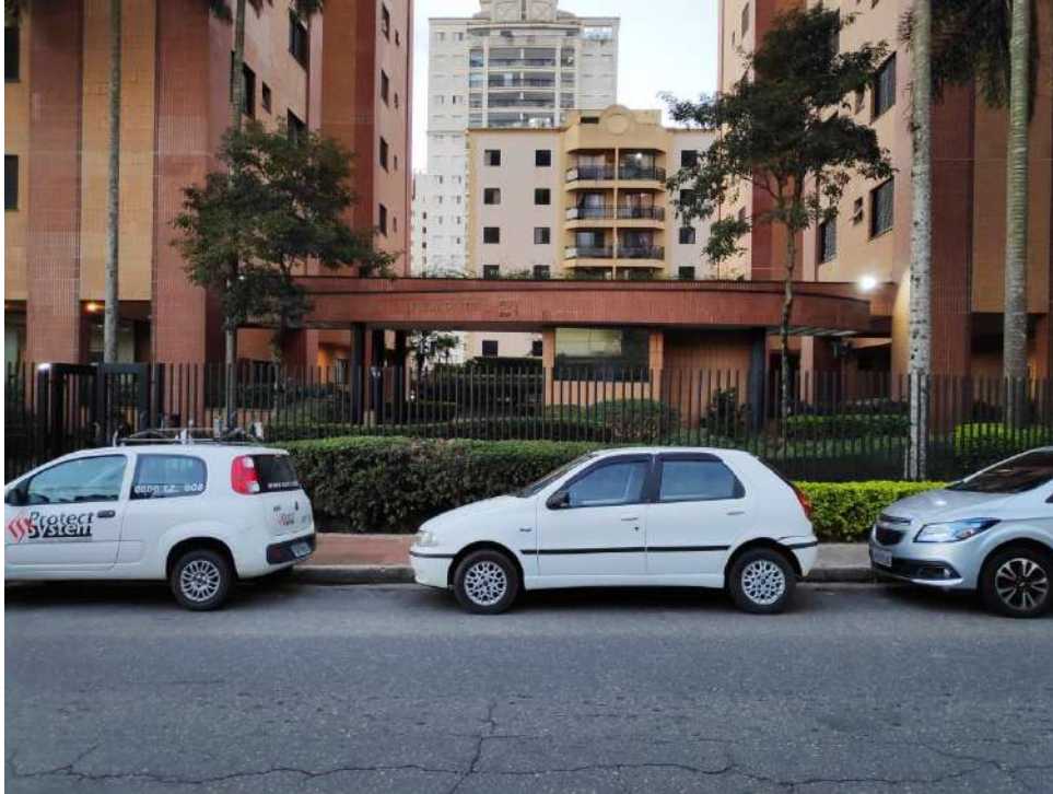
Figura 3 - Entrada do condomínio
