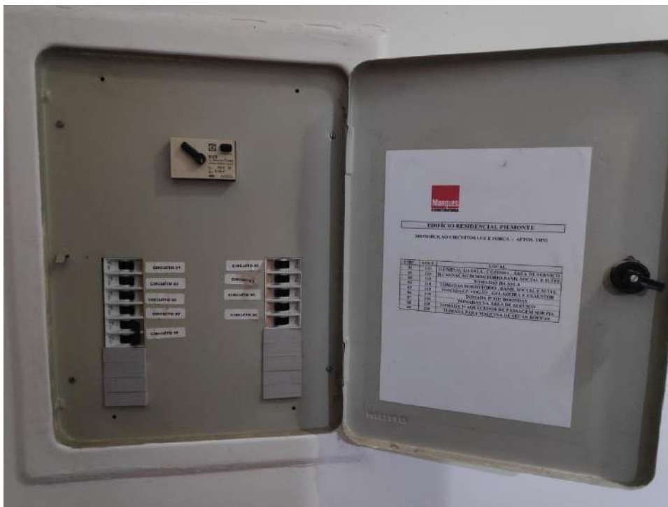
Figura 50 – Quadro de luz
