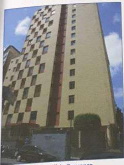
Foto 3 - Vista do Edifício Provença
