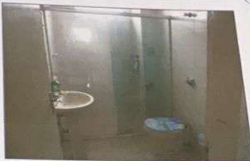
Foto 8 - Vista interna do banheiro apartamento avaliado
