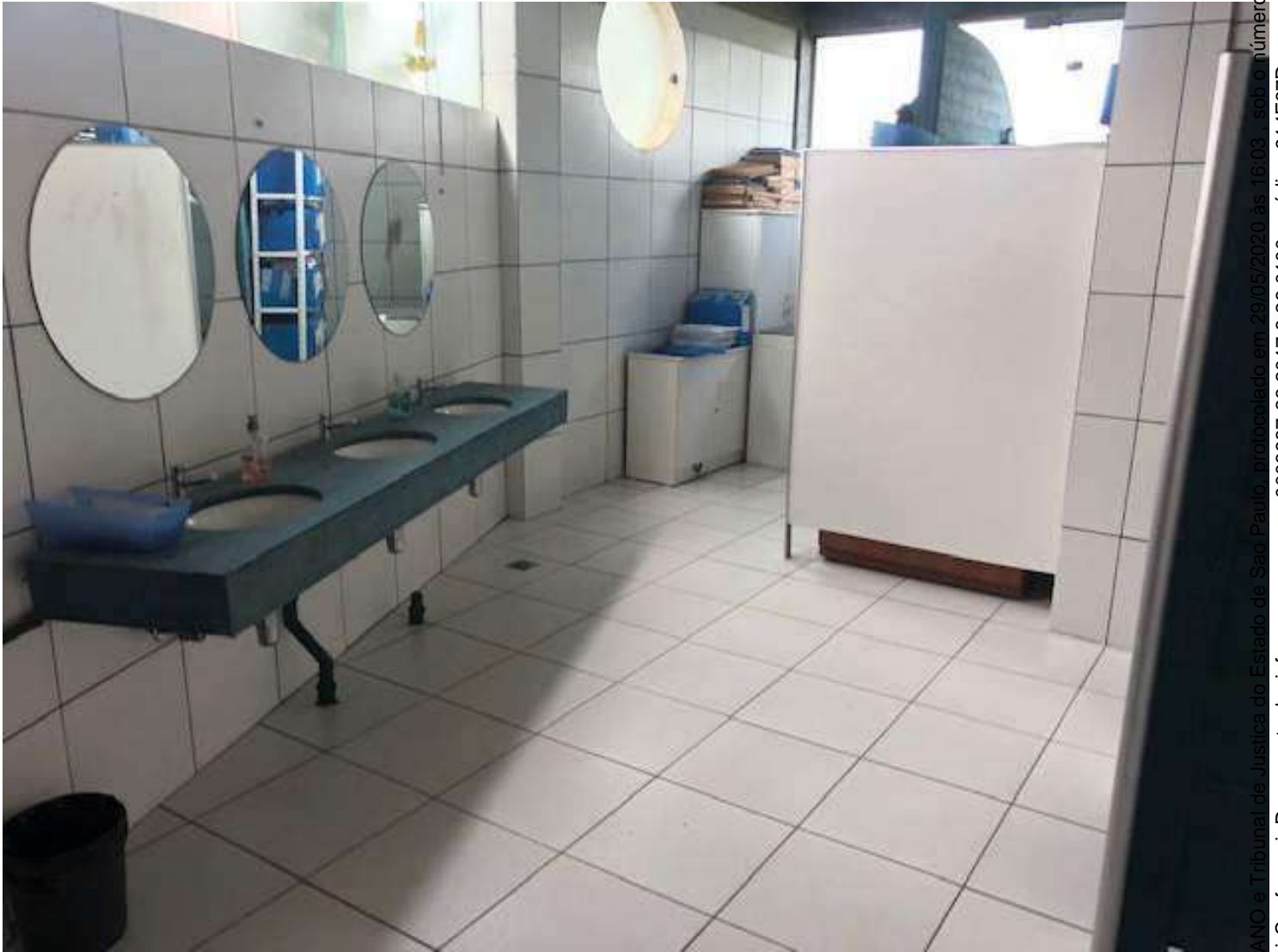
Foto 25: WC/vestiário da área de escritório.
