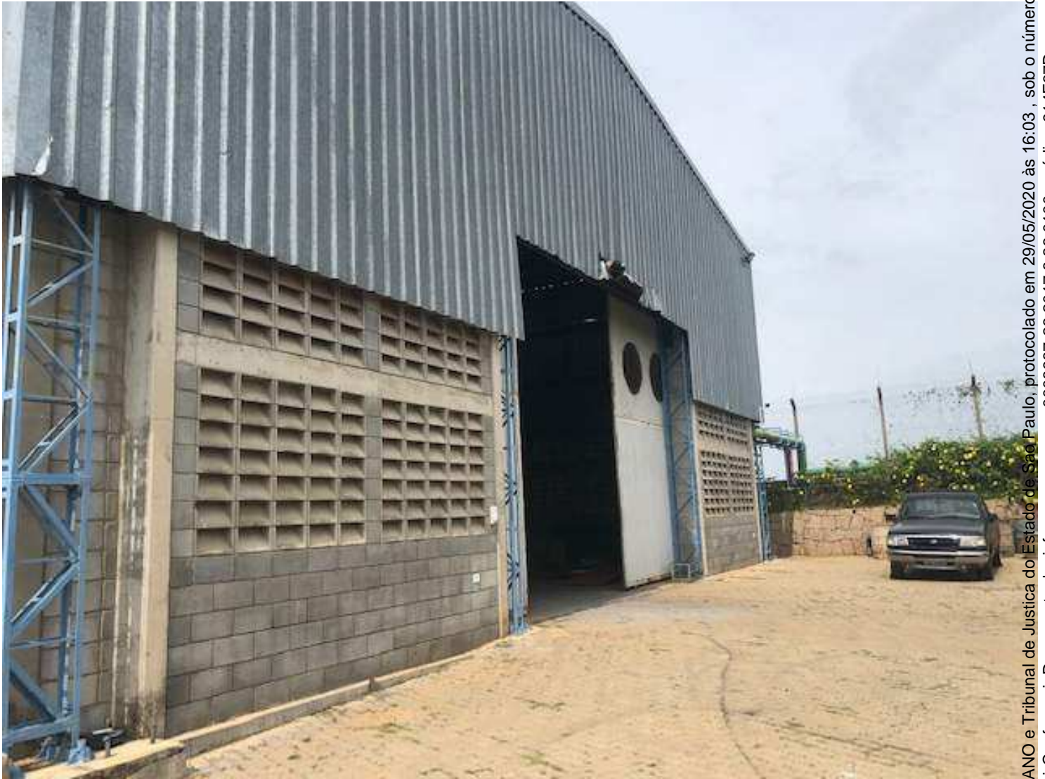
Foto 7: Vista da área externa do imóvel.
