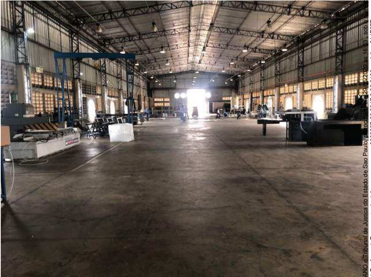
Foto 1: Vista interna do galpão.
