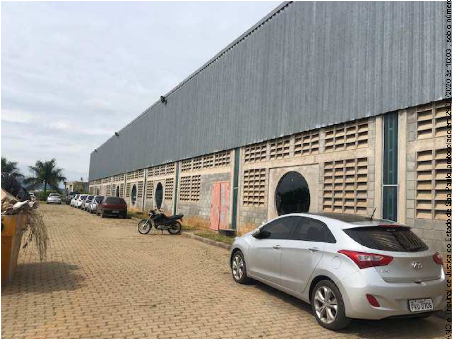
Foto 3: Vista da área externa do imóvel.
