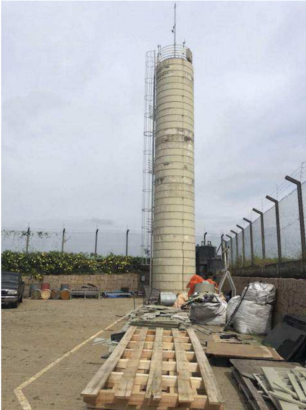
Foto 5: Vista da área externa do imóvel – caixa d'água.
