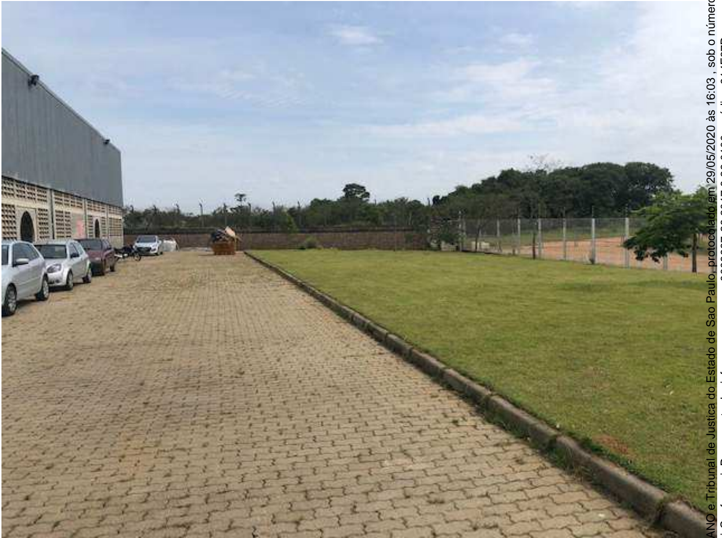
Foto 2: Vista da área externa do imóvel.
