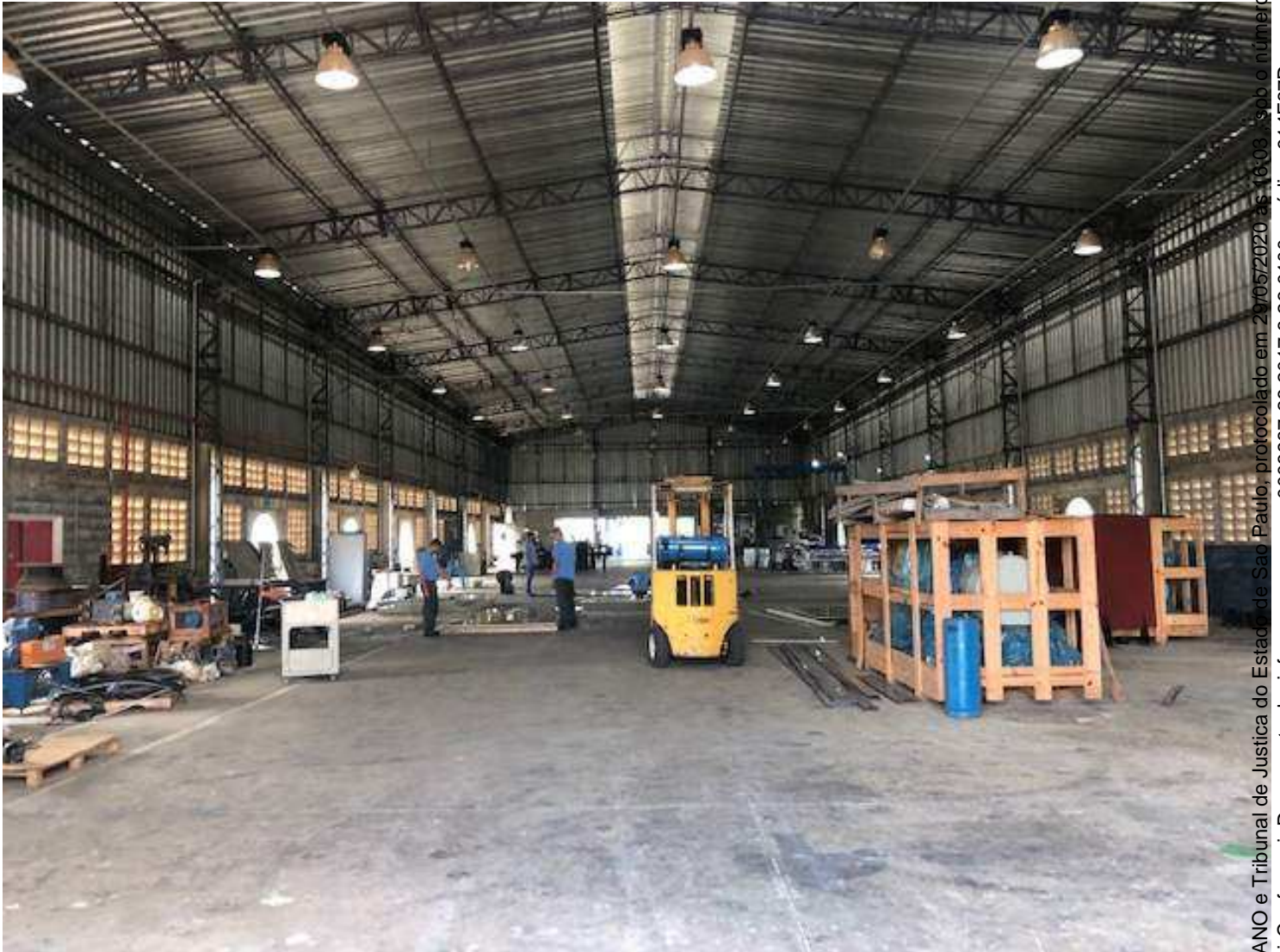
Foto 6: Vista interna do galpão.
