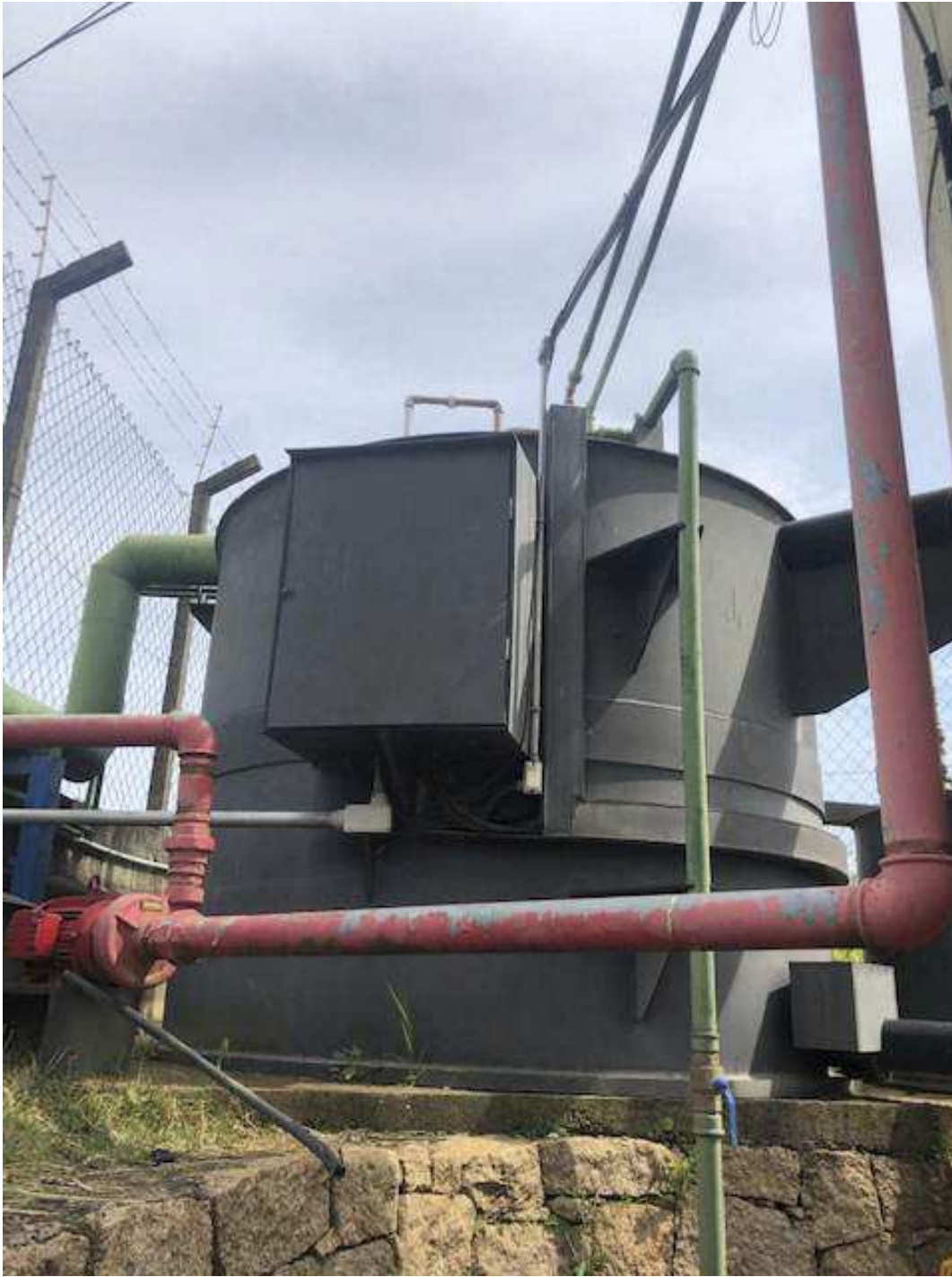
Foto 6: Tratamento de água.
