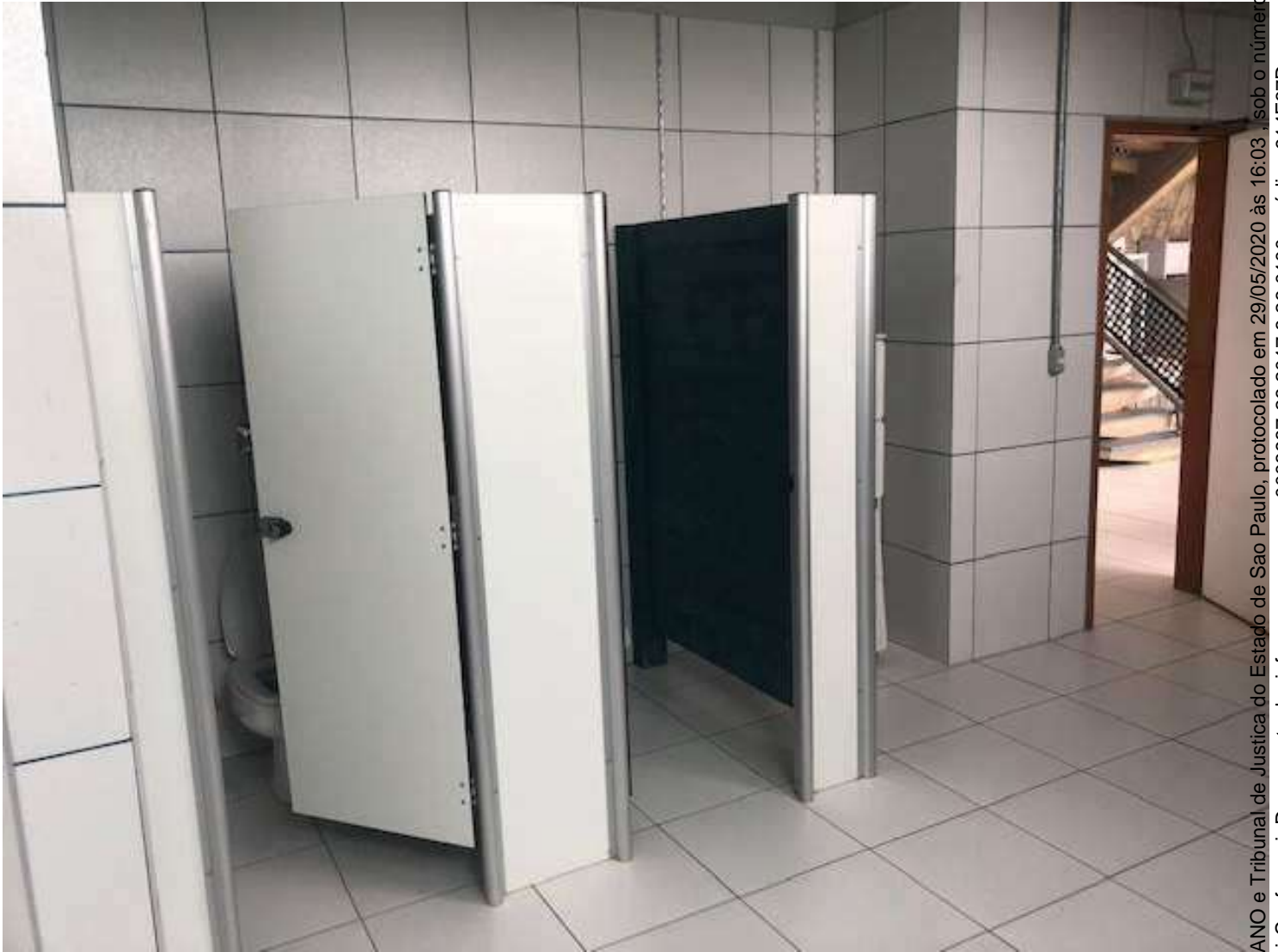
Foto 26: WC/vestiário da área de escritório.
